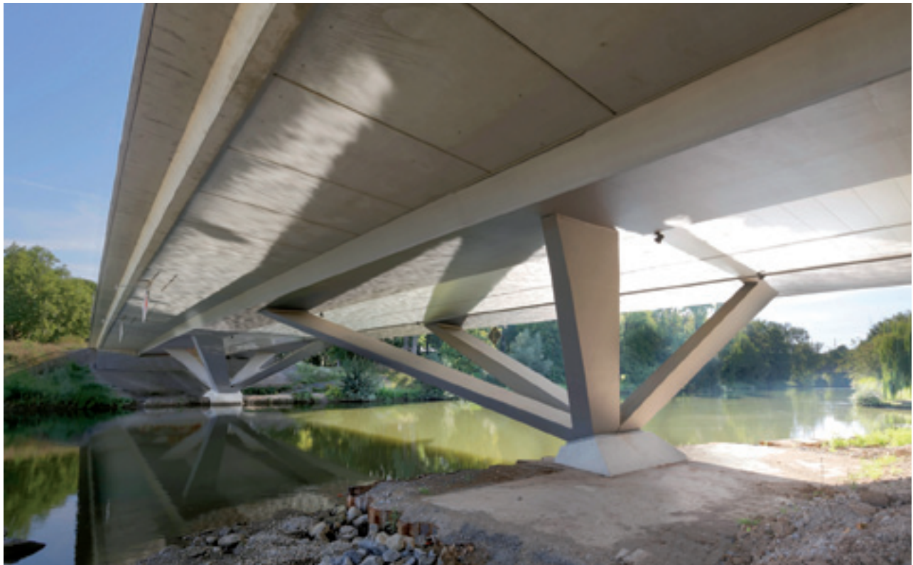
Bleichinselbrücke Heilbronn, Verbundkonstruktion mit oberliegender Betonfahrbahnplatte (Halbfertigteile) und Stahlhohlkästen als Längsträger.
