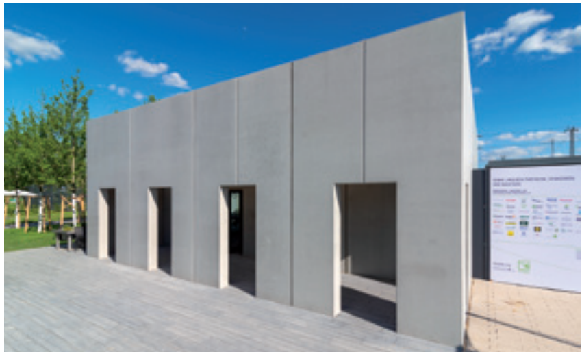
Ein ruhiger und kraftvoller Baukörper: der demontable Seminarpavillon aus Sichtbeton auf der Bundesgartenschau in Heilbronn.
