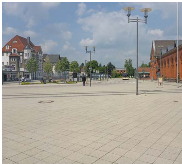
ZOB Detmold, Betonpflasterflächen mit TiO 2 -Beschichtung.
