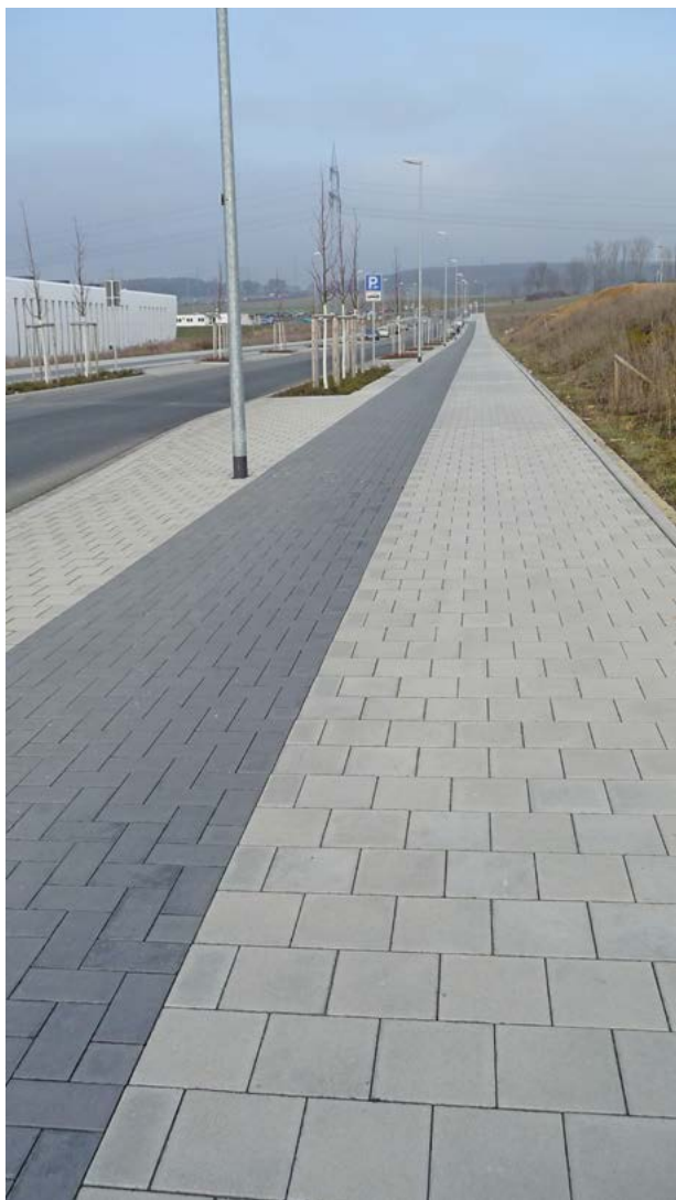
Photokatalytisch wirksames Pflaster lässt sich auf angrenzenden Flächen an viel befahrenen Straßen einsetzen. So werden die Schadstoffe direkt dort abgebaut, wo sie entstehen.
